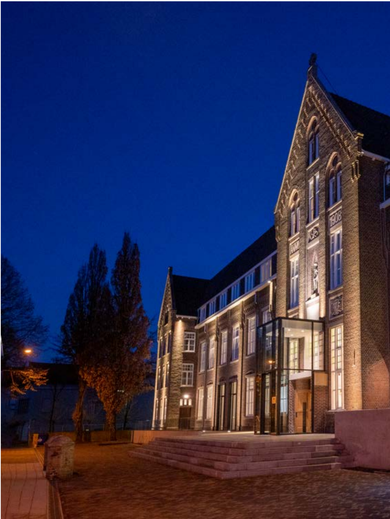
Hotel DoubleTree by Hilton Sittard Nederlands, project: Lueur B.V. Maastricht, HOMIJ Technische Installaties Ittervoort, photo: Anton Daal fotografie Hotel DoubleTree by Hilton, Sittard, Holandia, projekt: Lueur B.V. Maastricht, HOMIJ Ittervoort Instalacje techniczne, fot. Anton Daal fotografie
